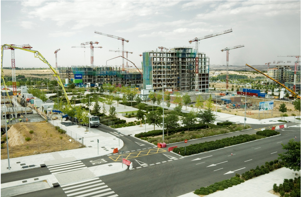
Vista actual de obras en construcción en Valdebebas
